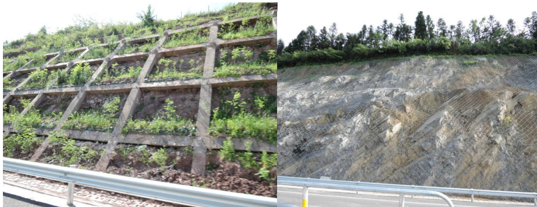
路基防护实景图
